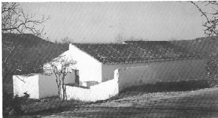
Fig. 4.27 House in Quatro estradas, Lagos (AAP 1961)
